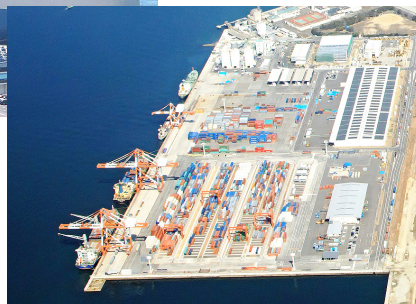
広島港国際コンテナターミナル（出島地区） 広島港 広島県空港港湾部提供
