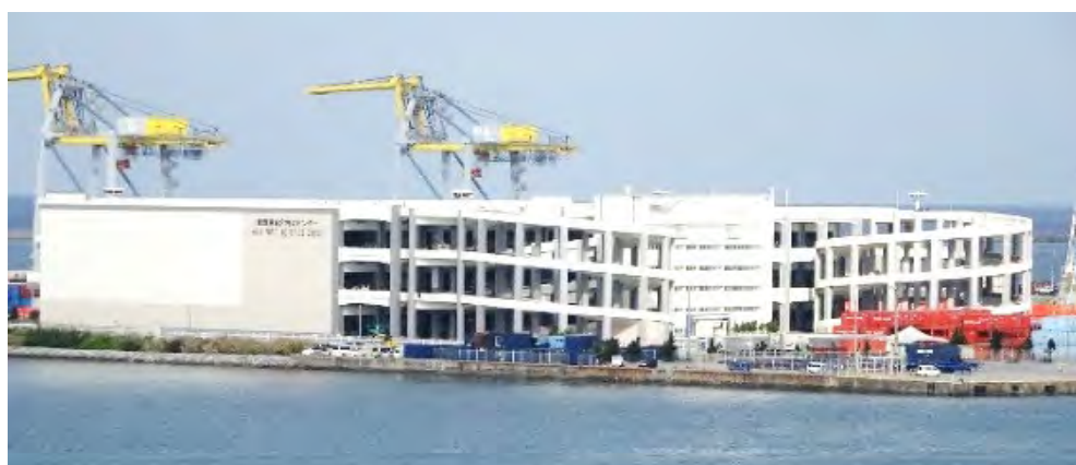
図ー5 完成した那覇港総合物流センター
