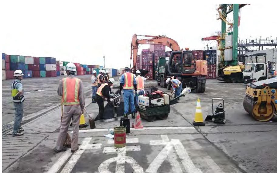
図6 コンテナターミナル復旧作業の様子
