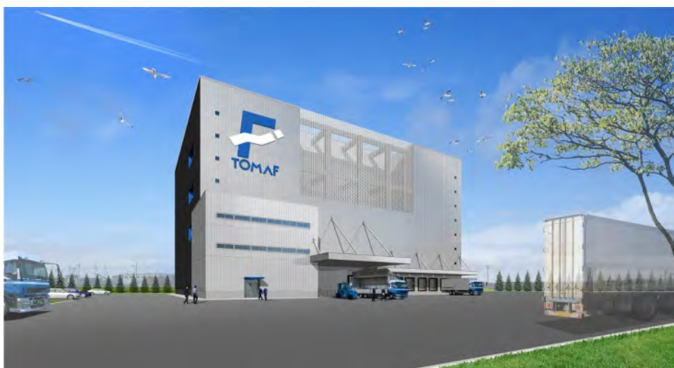
図4 建設中の温度管理型大型冷凍冷蔵倉庫(イメージ)
