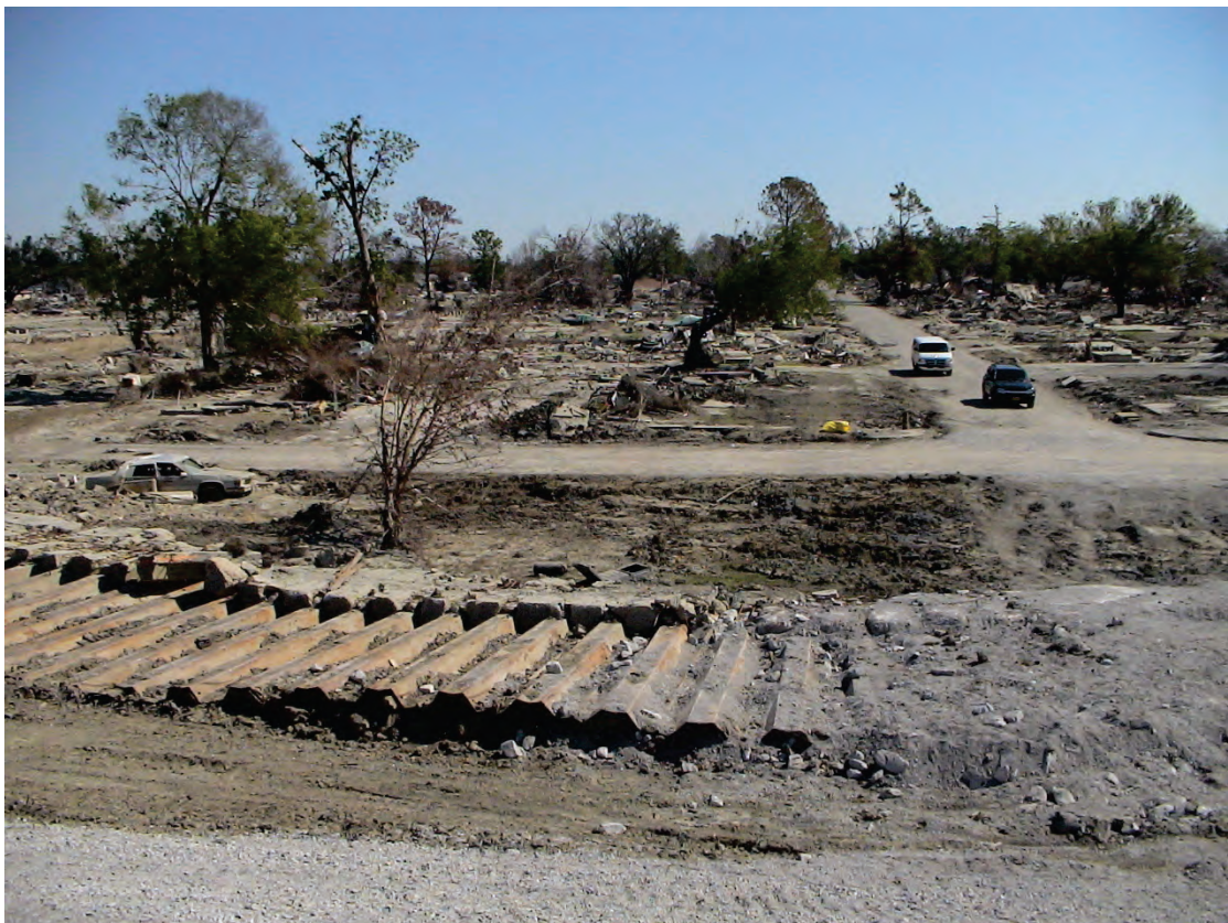
写真-2 ニューオリンズの現地調査（運河堤防の倒壊と破壊された住宅地）
