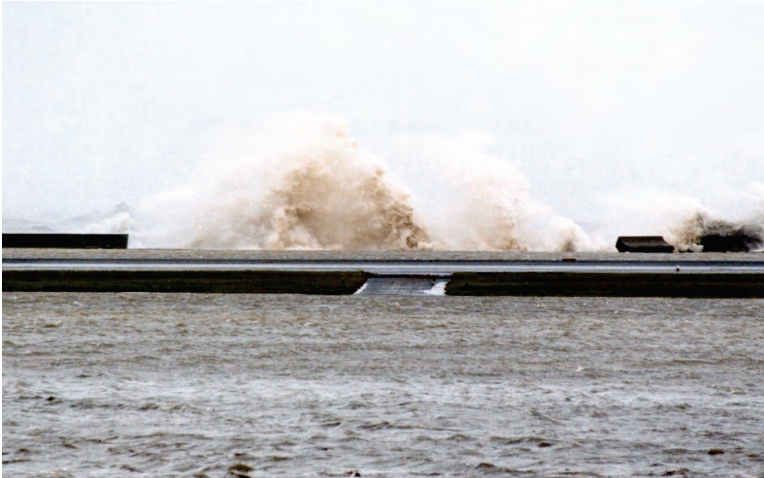
写真-1 宇部空港の滑走路と護岸（高潮に加えて高波による護岸の倒壊）
