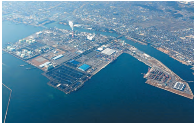
霞ヶ浦北南ふ頭コンテナターミナル（四日市港） 写真提供 名古屋四日市国際港湾株式会社
