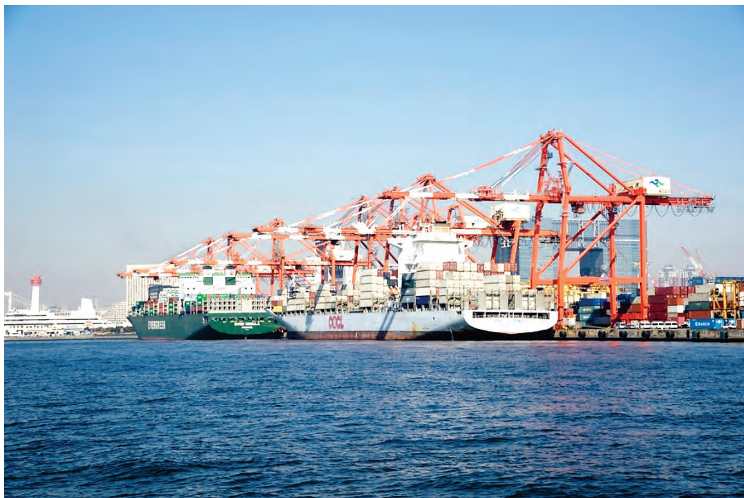
青海コンテナ埠頭(写真提供:東京都港湾局)
