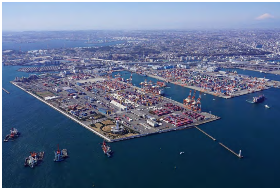
横浜港 本牧ふ頭コンテナターミナル
