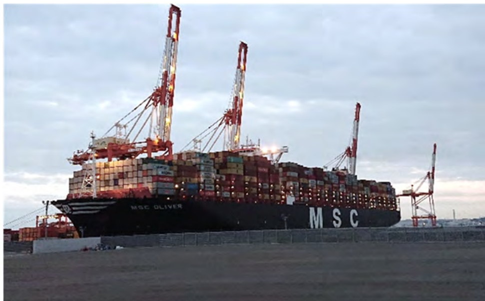
横浜港 南本牧ふ頭コンテナターミナル 大型船着岸時の様子
