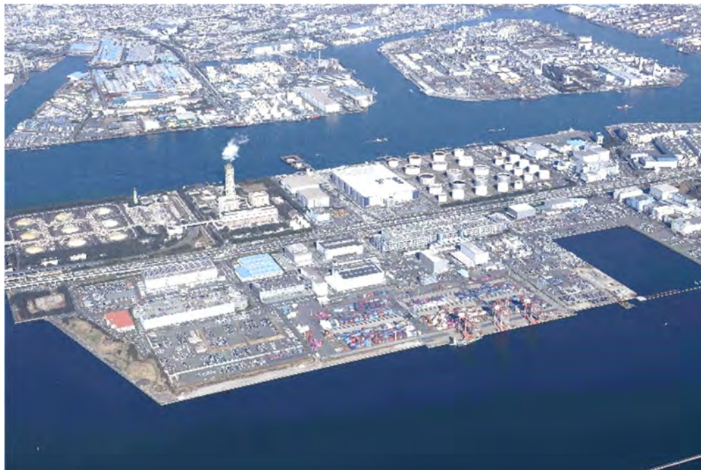
川崎港東扇島ふ頭 航空写真（川崎市港湾局提供）
