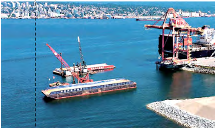
(左図) 拡張工事が進んでいる Centerm Container Terminal9
