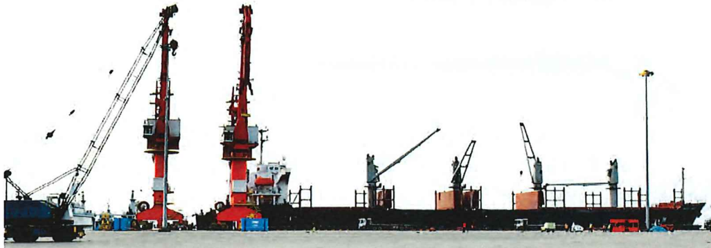
(写真) クリビ港多目的ターミナル
