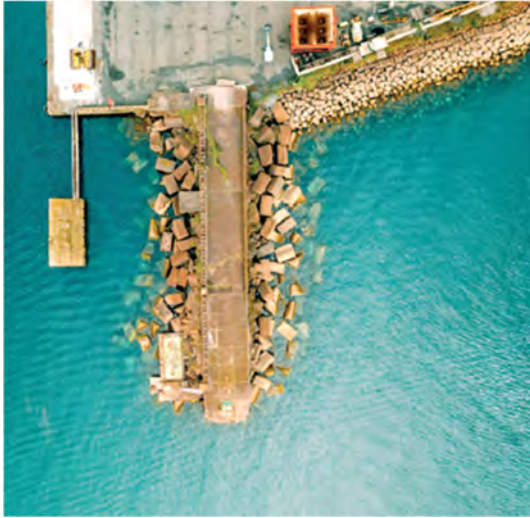
(写真) 港湾にはコンクリートが多用されている。
