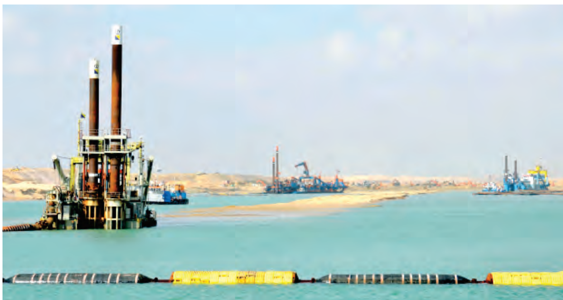
(写真) エジプト、イスマイリア地区 2015 年のスエズ運河の拡張工事 一方通航航路を双方向航行可能とする運河拡張
