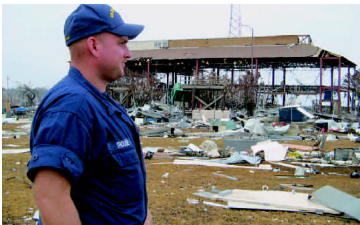
写真 廃墟 カトリナ襲撃まで沿岸警備隊基地として使われていた残骸を再調査する沿岸警備員
