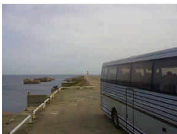
写真-3 シネス港防波堤先端部
