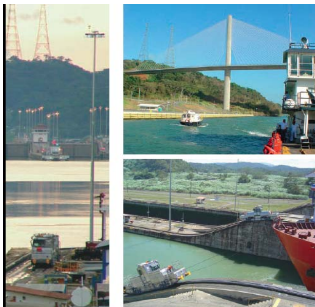
(上)百年祭大橋はやがて拡張水路をまたぐ (下)ミラフロレス閘門の新牽引車「ミュール」
