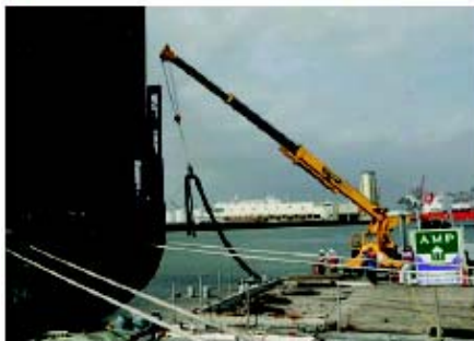
(写真 上)バージは港の全域で電源を供給できる(写真 下)
