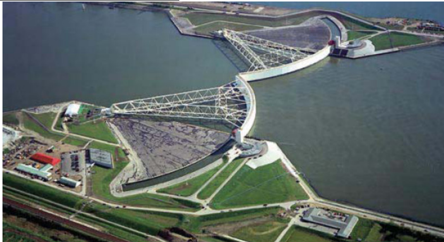
ロッテルダム: マエスラント防潮堤が東部エリアを保護している。
