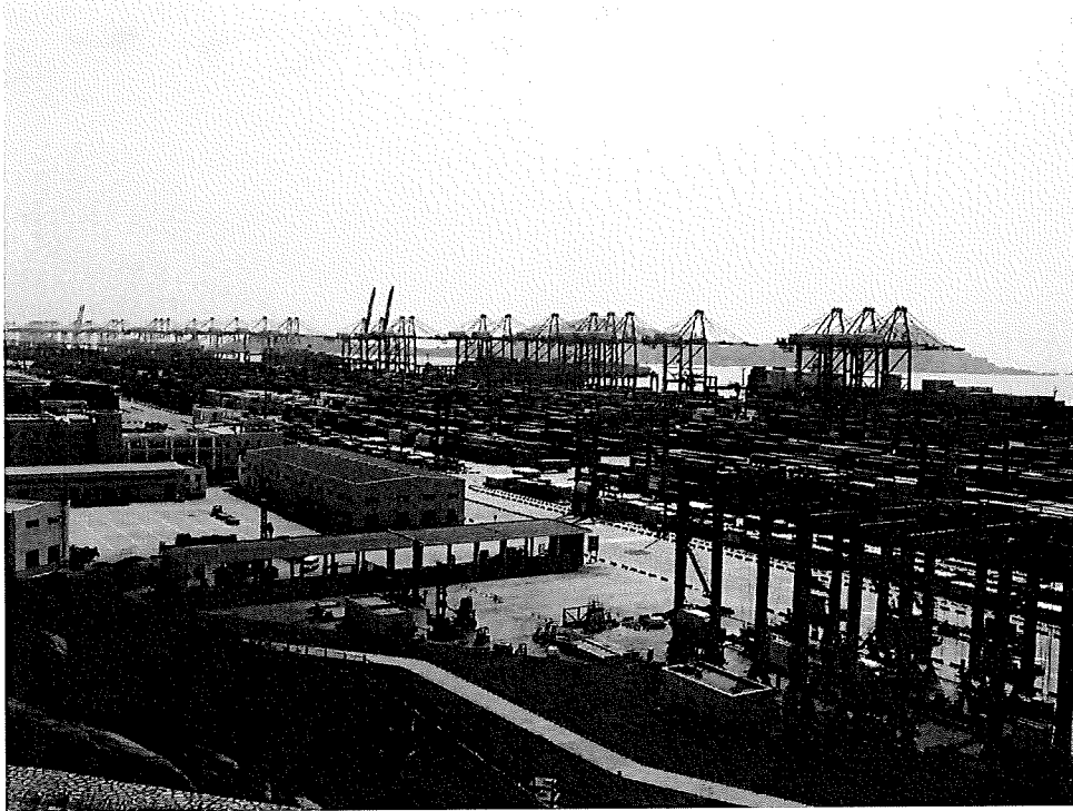
ヤード内コンテナは、実入りは4段、空は5段積み。ガントリークレーンの背後に大洋山島が見えます。
