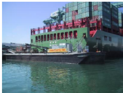
バージからの代替電源供給の様子
